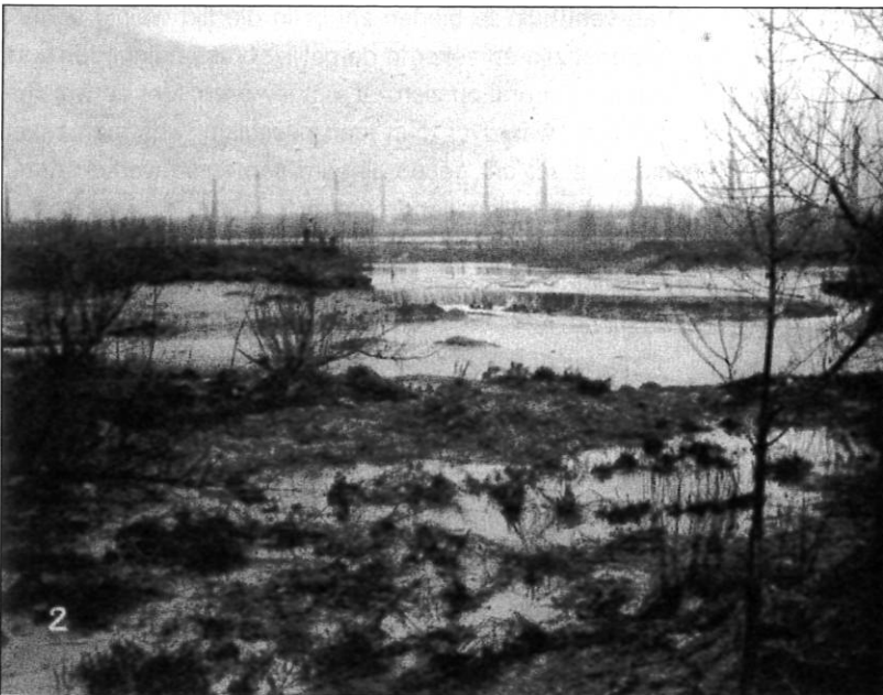
December en januari zijn blijkbaar de gevaarlijkste maanden voor stormweer met overstromingen. In december 1936 was er een zoveelste dijkbreuk waarbij de landerijen overstroomd werden. Verz. J. De Vuyst
